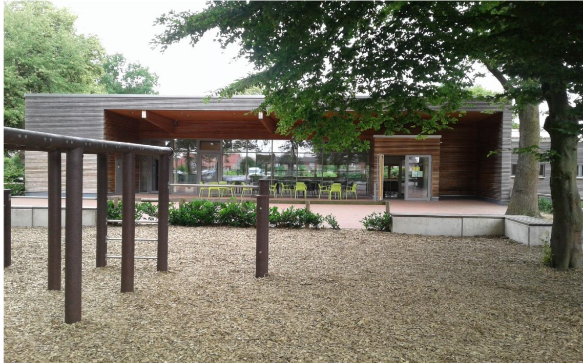
Mensa der Profilschule Ascheberg am Standort in Ascheberg
